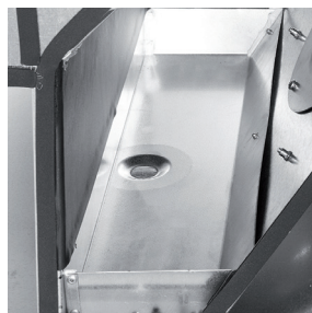
Tava za kondenzat Tava za kondenzat s otvorom na dnu.
