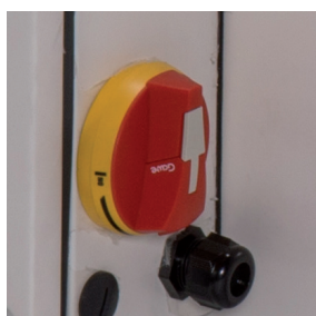
SERVISNA SKLOPKA Sve izvedbe uključuju ON/OFF servisnu sklopku.
